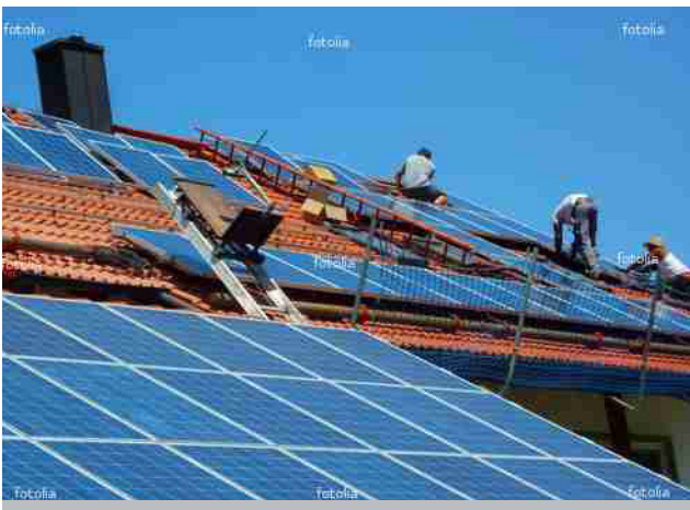
Abb. 15: Installation von Photovoltaikanlagen
